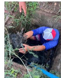
การลอกท่อน้ำอุดตันเพื่อ ป้องกันน้ำท่วมขัง
